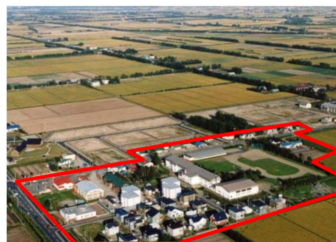
【夕張太地区(南幌町)H9完了】
